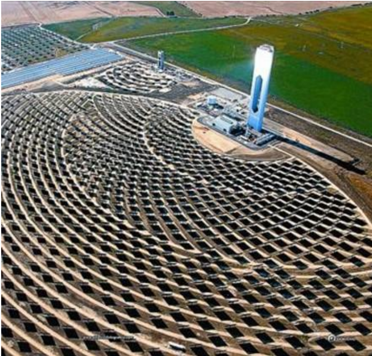
CENTRAL TERMOELÉCTRICA (SANLÚCAR LA MAYOR, SEVILLA)
