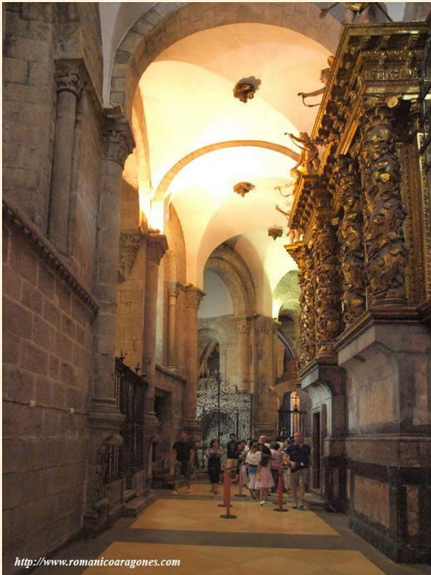
Bóvedas de arista de la girola
