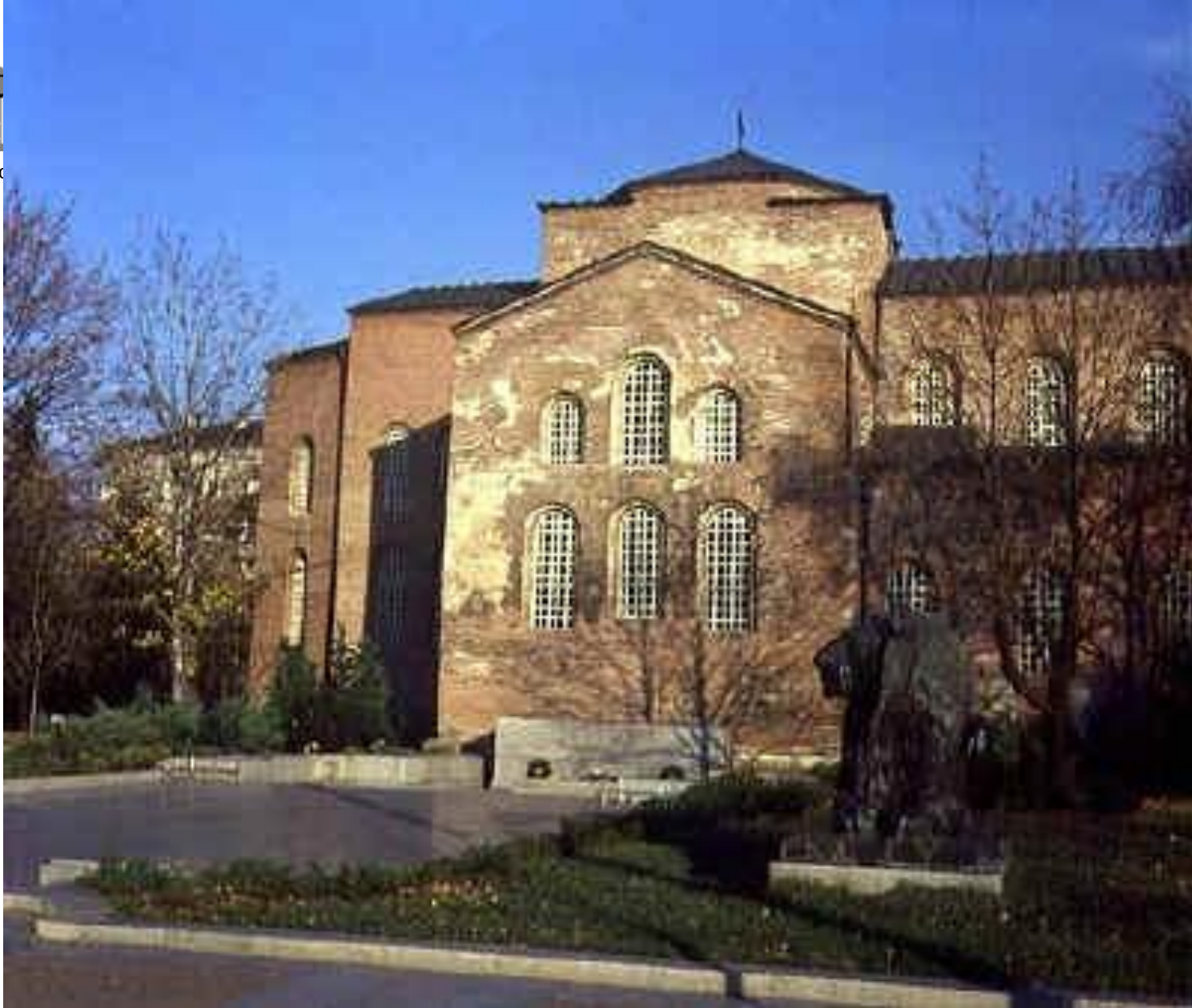
Santa Sofía de Bulgaria. Pobreza muros exteriores
