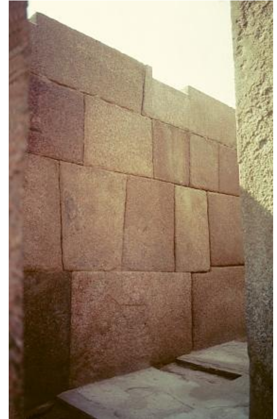
Muro de sillería irregular
