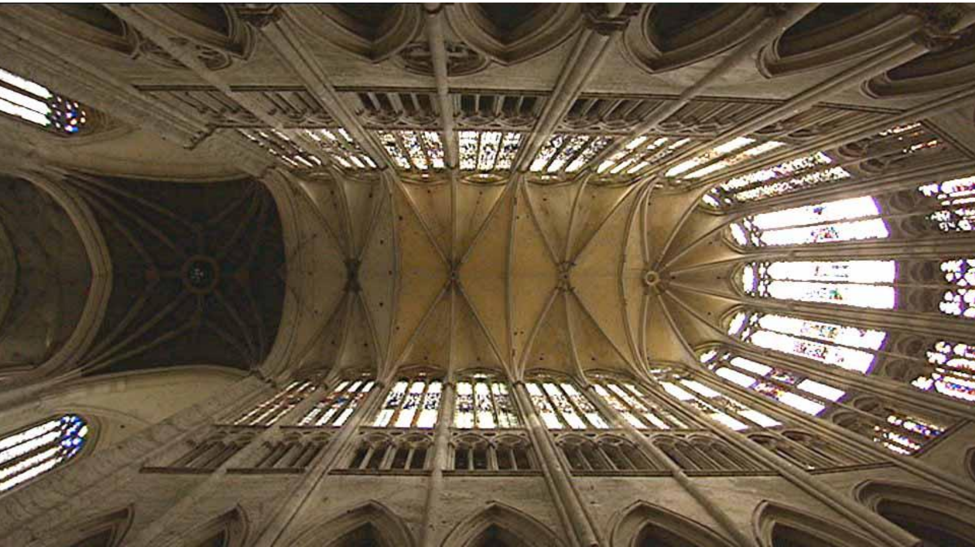
Cubiertas. Bóveda sexpartita
