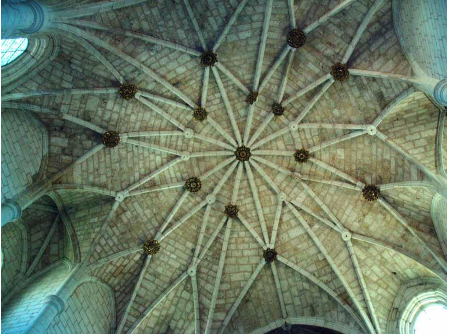
Cubiertas. Bóveda estrellada
