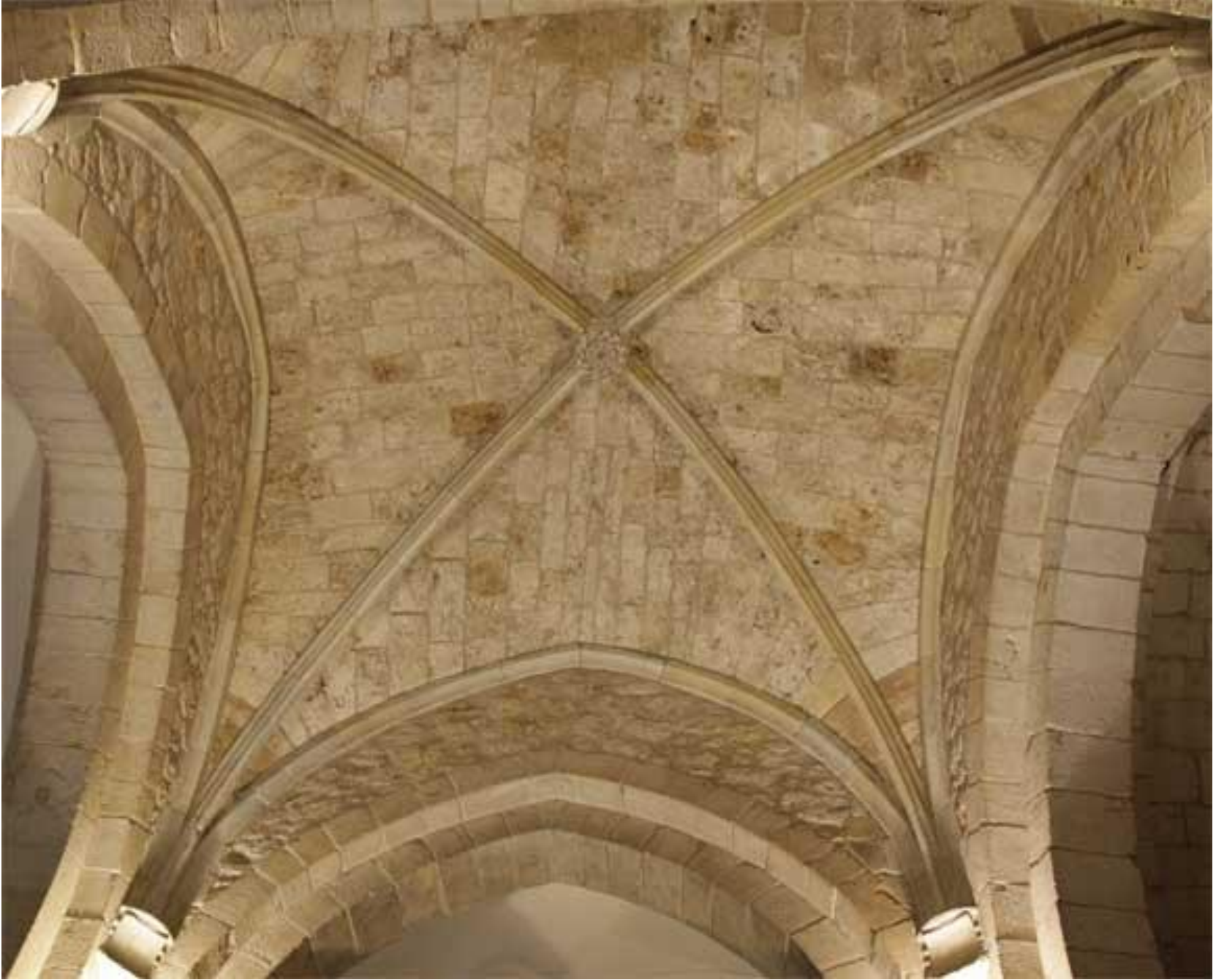
Cubiertas. Bóveda de crucería
