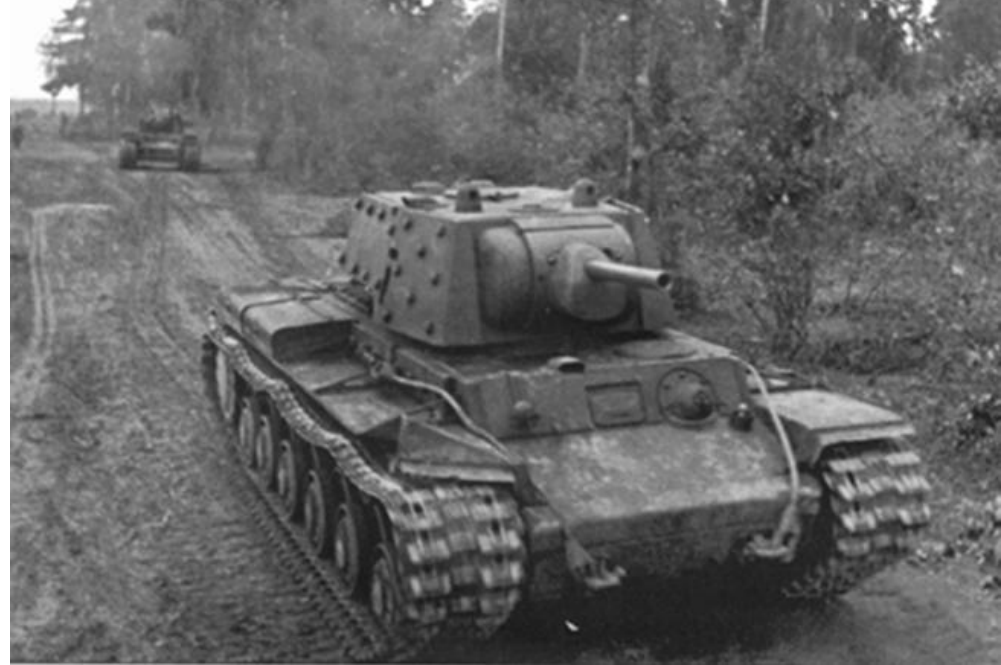
Carro de combate soviético KV-1. Pesadamente acorazado y armado con un cañón de 76,2 mm. de alta velocidad, el KV-1 era un enemigo formidable para los carros alemanes de 1941.
